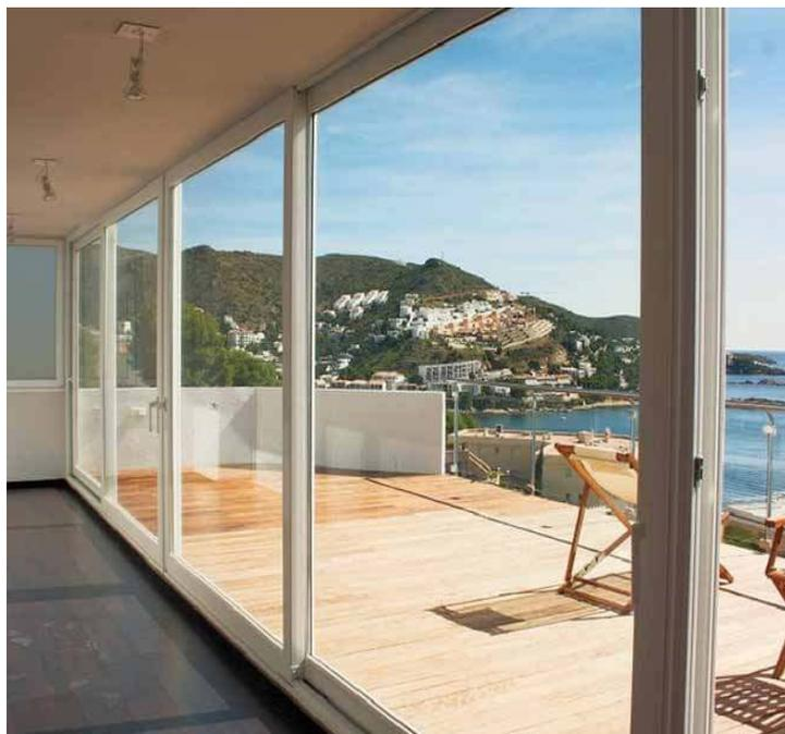
Classe : EN12608 - Classe A Coefficient de transmission thermique :  $U_w = 1,2 \text{ W/m}^2\text{K}$
