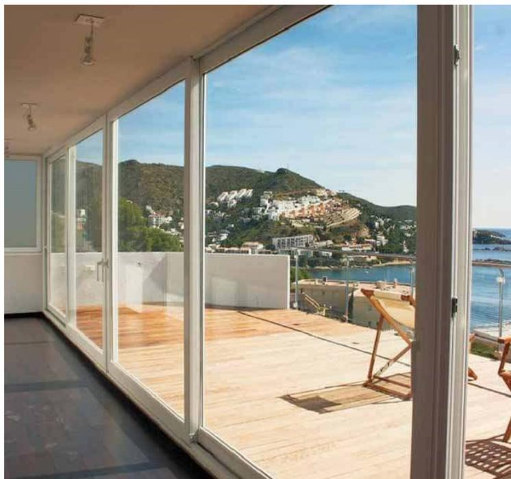
**Coefficiente di trasmittanza termica:**  $U_w = 1,2 \text{ W/m}^2\text{K}$
